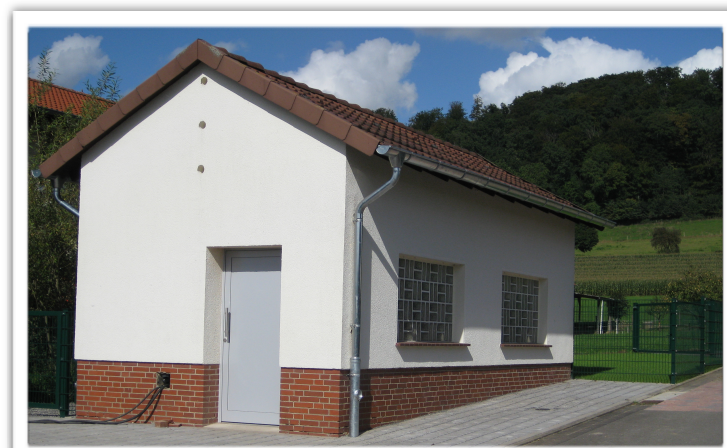
Das Pumpenhäuschen in seiner neuen Pracht
