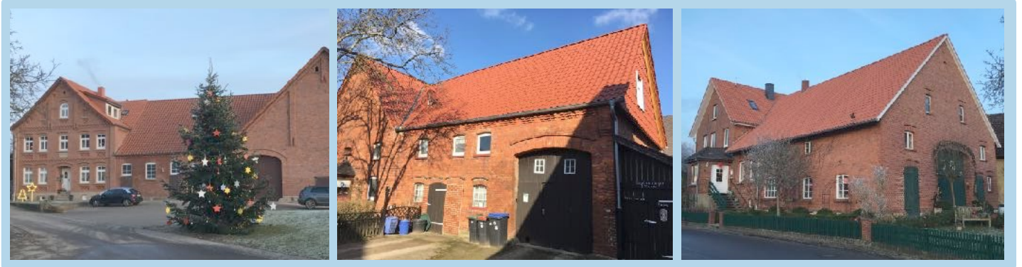
Das Haus Eickmeyer mit neuem Dach, die Fassade wurde sandgestrahlt und neu verfugt.
